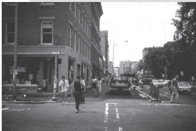
NEW HAVEN, CHANEL STREET PODCZAS PRZEBUDOWY
